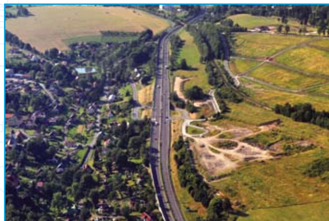
MÚK Jeřmanice po rekonstrukci
